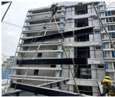
图7 现场钢梁吊装
