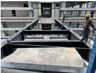
图9 钢次梁通过马板悬挂在主梁上
