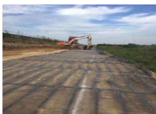
图4 土工格栅铺设
