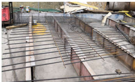
单面钢筋施工安装示意图
