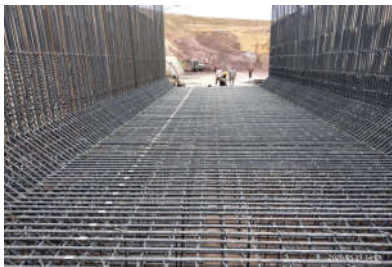
图1 水利混凝土工程现场图
