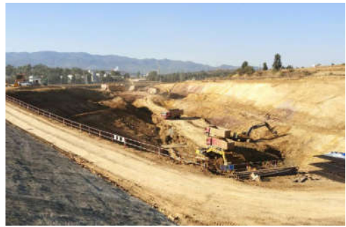
图2 混凝土工程施工现场
