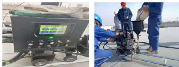
图2 (左)底板焊接小车参数设定采集;(右)底板焊接操作图
