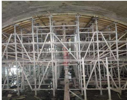
图3 拱顶混凝土浇筑
