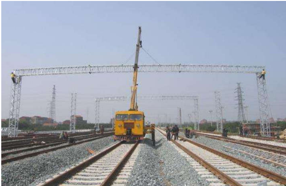
图1 铁路工程路基施工
