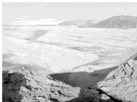
图3 第四系按 45^\circ 施工后边坡稳定
