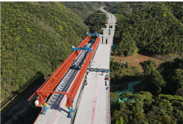
图 4 JQ400t-60m 型架桥机
