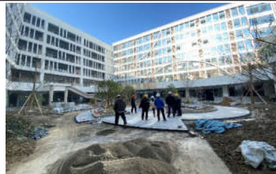
图2 杭州市采荷实验中学（EPC）项目工程设计人员驻场
