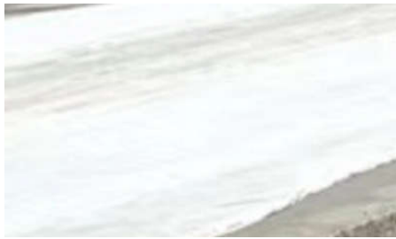
图2 混凝土路面施工前铺设防渗土工布
