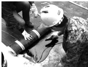
图3 DTSD防水层施工
