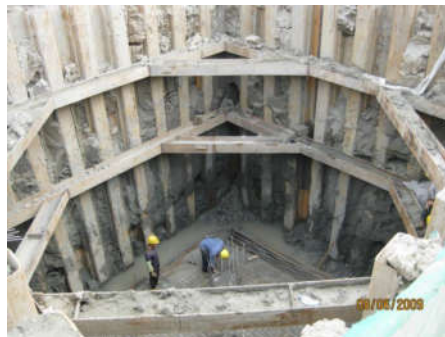
图2 桥梁深基坑钢板桩支护
