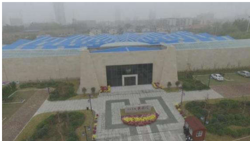
图1 土遗址防护网架现状图
