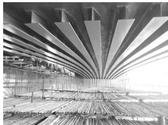
图4 工字钢梁加固施工
