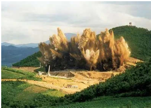
露天矿山爆破如图一所示
