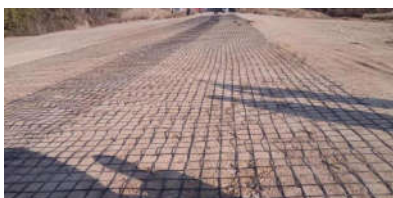
图(3) 土工格栅铺设
