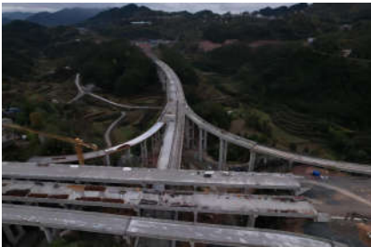
图6 青杠坡互通C匝道桥T梁安装完成
