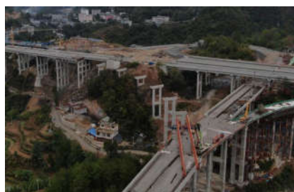
图2 青杠坡互通C匝道架桥机拼装
