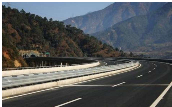
图3 挖凿隧道建设的山区公路
