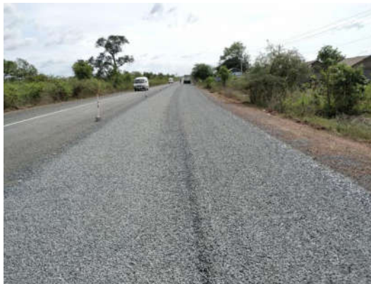
图2 橡胶沥青摊铺施工橡胶沥青摊铺后进行碾压
