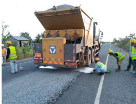
图1 橡胶沥青摊铺施工橡胶沥青摊铺后进行碾压
