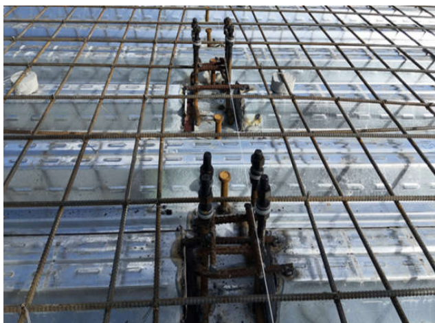
图1 工艺优化前预埋螺栓安装
