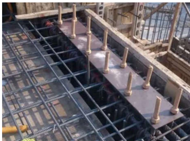
图2 工艺优化后预埋螺栓安装
