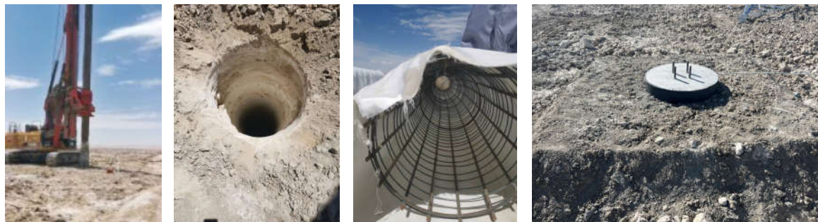
图1 施工现场效果图
