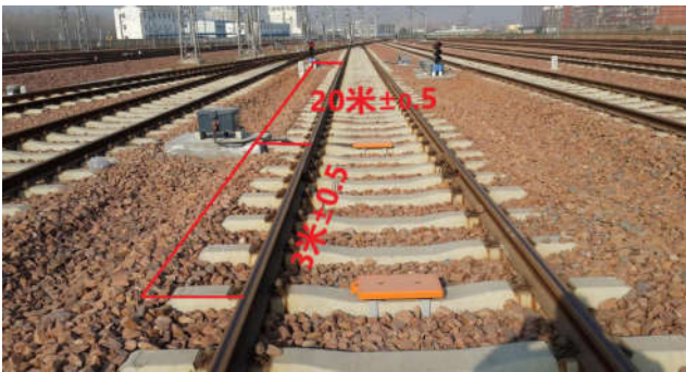
图2 调车防护应答器组布局示意图
