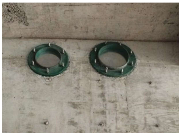
图6 柔性套管临时封堵实物图
