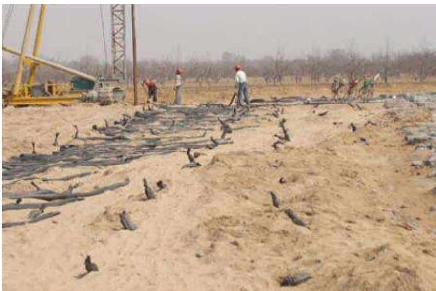
图1 软土地基表层处理现场
