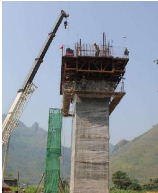
图3 桥梁翻模施工现场
