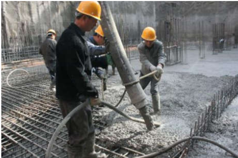
图2 混凝土施工现场
