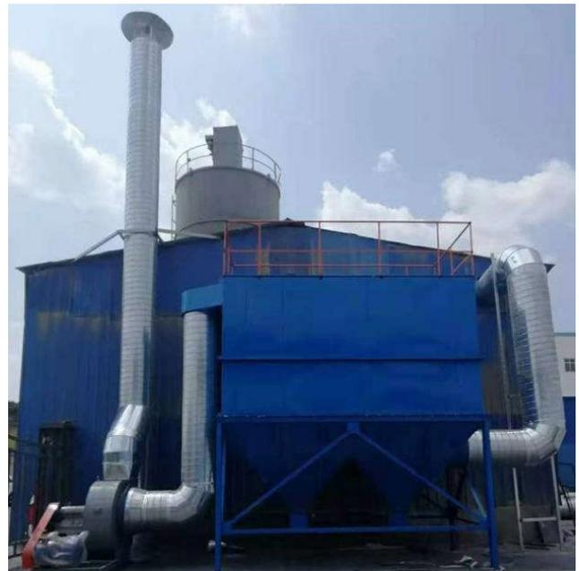
图3 除尘系统现场布置示例
