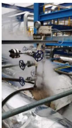
图一: 现场焊缝开裂位置
