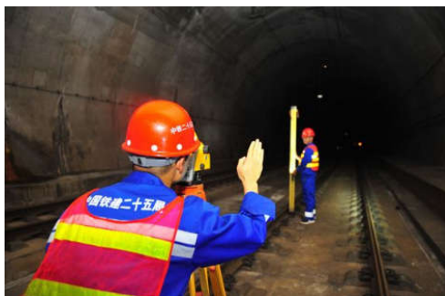
图1 地铁盾构施工现场
