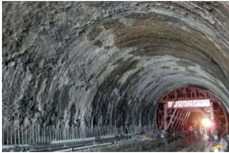
图1 混凝土整体浇筑
