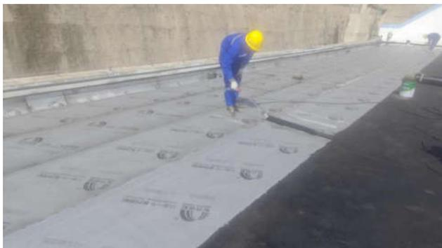
图2 PMB-742超低温（SBS）改性沥青防水卷材施工
