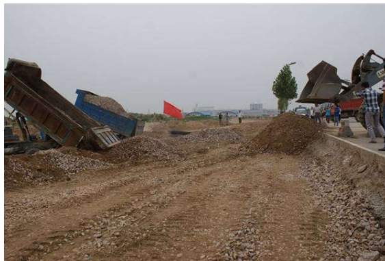
图1 铁路工程建设
