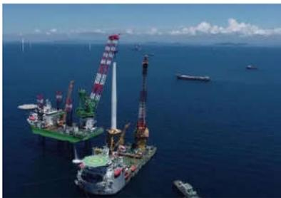
图1 国内最重海上升压站（粤电阳江青洲一、青洲二海上风电项目）吊装
