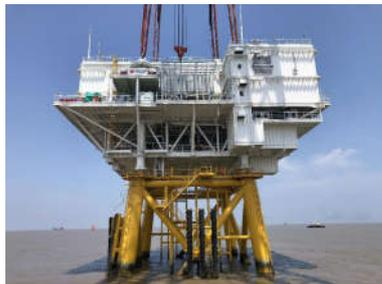
图2 国内首个模块化海上升压站（宁波象山1#海上风电场二期）吊装
