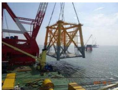
图4 导管架吊放示意图
