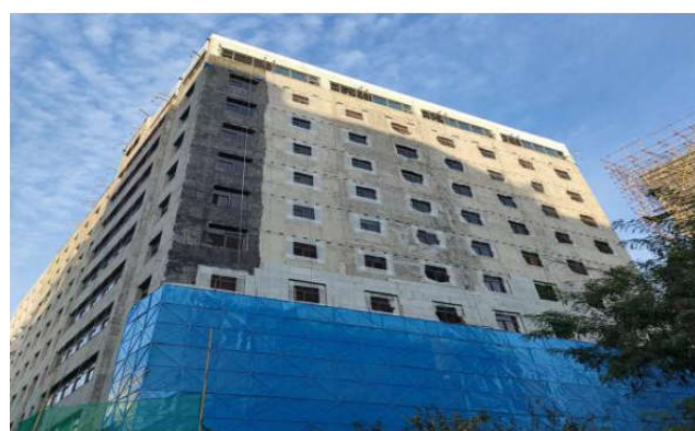
图2 某既有建筑外墙挂网抹灰施工阶段场景
