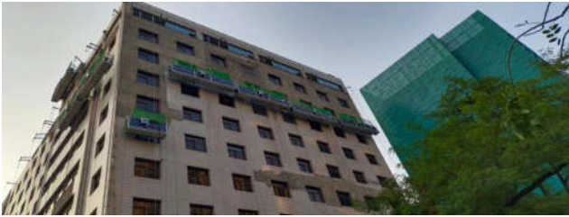
图1 既有建筑外墙节能改造施工现场
