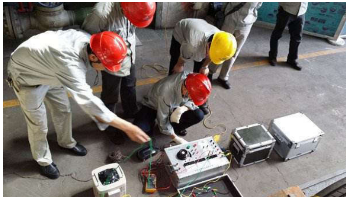
图3 排查接地线故障
