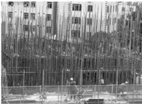
图1 高支模门架搭设
