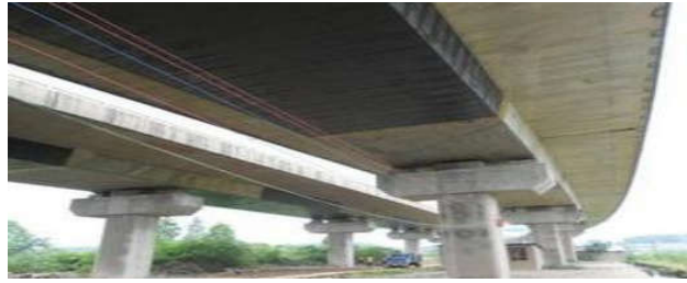
图3 青岛桥梁粘贴碳纤维板加固图
