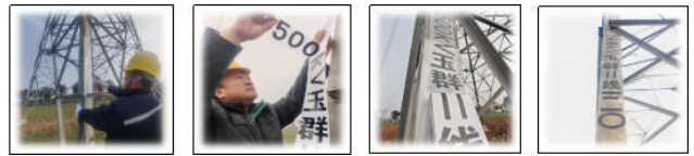
图2：杆塔标识施工步骤
