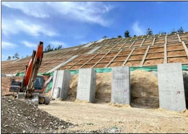
图5-1 抗滑桩施工图
