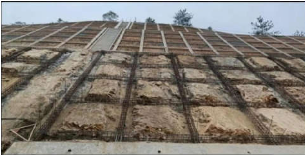
图5-2 路堑边坡施工
