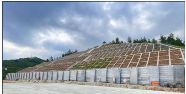
图5-3 边坡防护施工图
