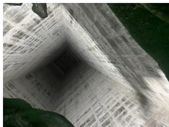
图 4 浇筑完成的竖井衬砌
