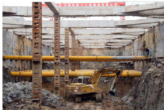
图1 基坑开挖现场图
