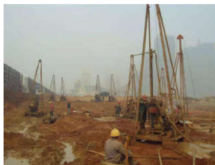
图2 岩土勘测现场
