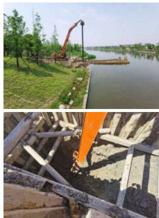
图3 拉森钢板桩围堰施打及障碍物挖除作业施工
