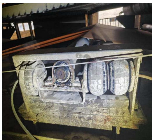
图2 纠偏滚筒及气囊
