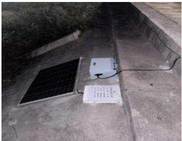
(b)铁路路基监测点布置现场图
