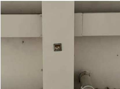
图2 风雨棚柱顶位移监测点布置图
