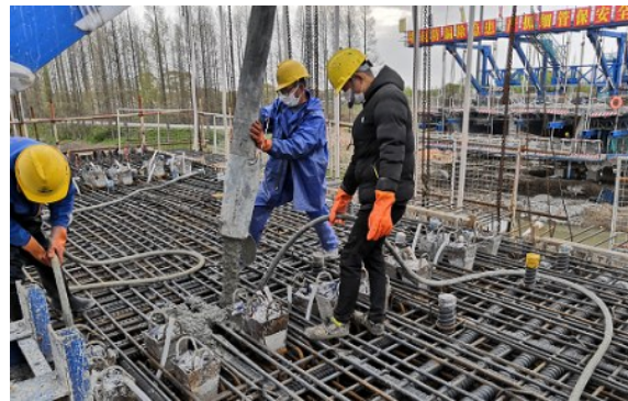
Fig. 3 concrete pouring
