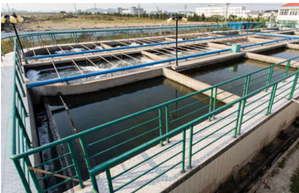
图2 岱山经济开发区的工业污水处理厂
