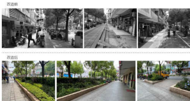
（图1：华发路华发小区段改造前后实景对比）
