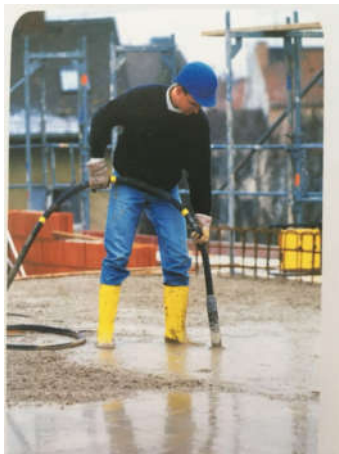
图3 混凝土人工振捣
