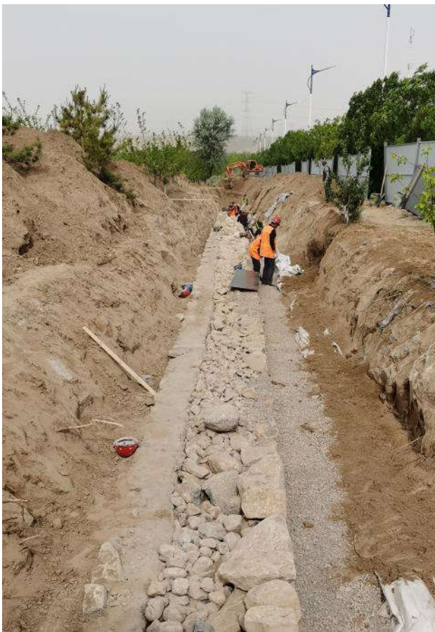
图3 截水盲沟施工现场照片
