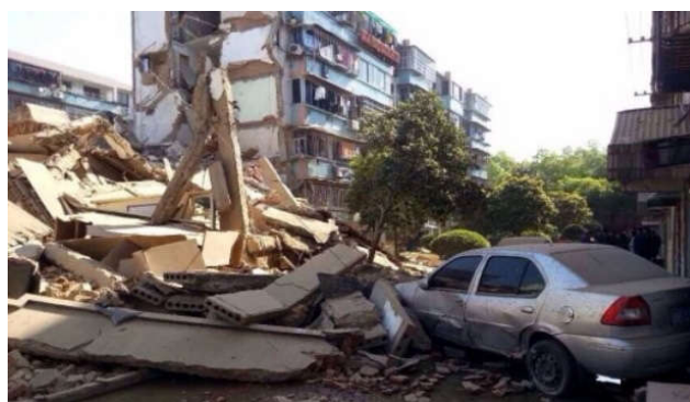
图2 奉化市锦屏街道居敬小区29幢居民楼局部坍塌
