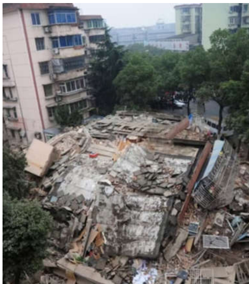
图1 宁波市江东区徐戎新村六层居民楼整体坍塌
