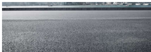
图3 沥青平铺紧密压实后铺面
